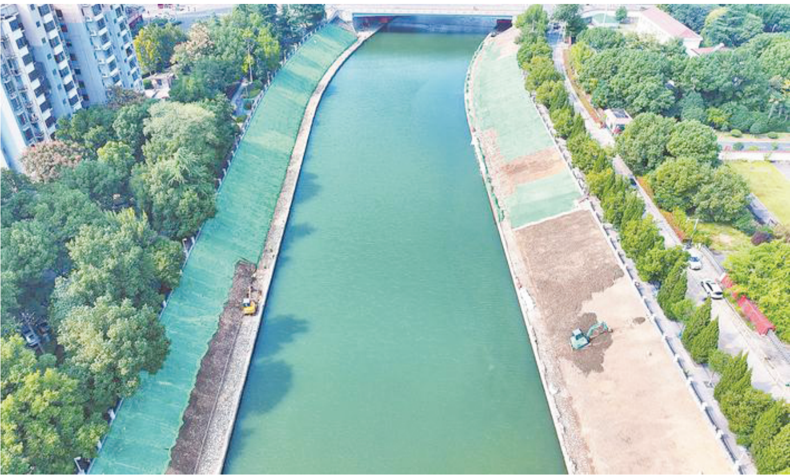
10月27日,南淝河肥西路桥至长丰路桥段施工现场一派繁忙。该河段正在实施岸线整治、水环境提升作业,持续改善南淝河滨水生态,加快打造绿色生态廊道,为市民营造亲水宜居的绿色游憩空间。
