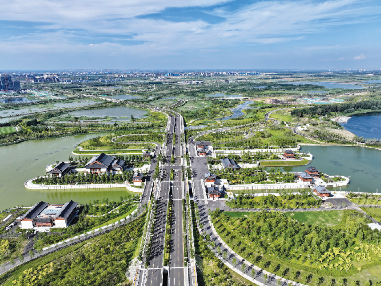
这是位于雄安新区启动区与白洋淀交汇处的南河枢纽（2026年8月4日摄，无人机照片）。 新华社记者 牟 宇 摄
