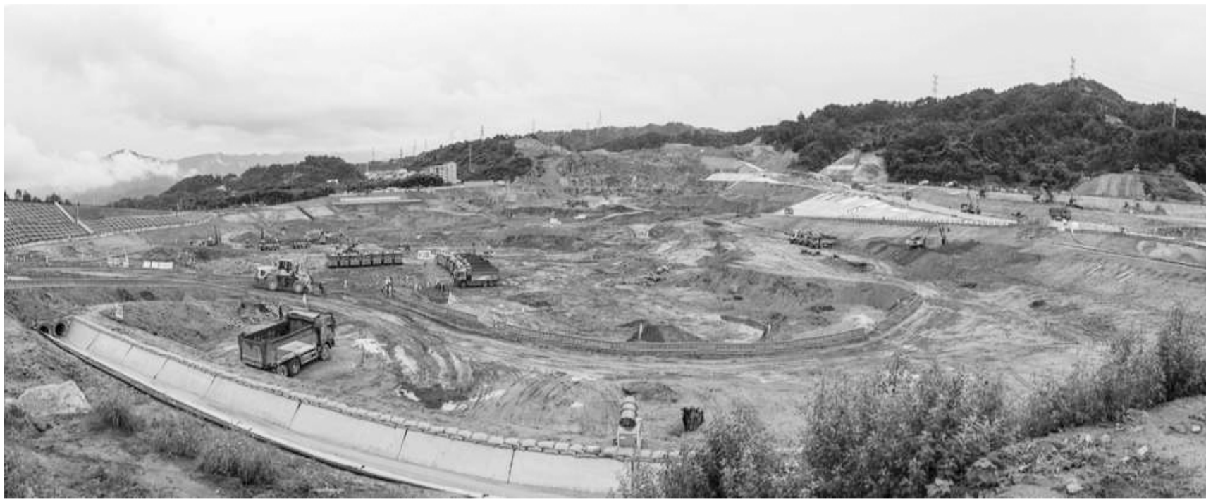
这是6月8日拍摄的三峡水运新通道工程先行开挖区施工现场(拼接照片)。
