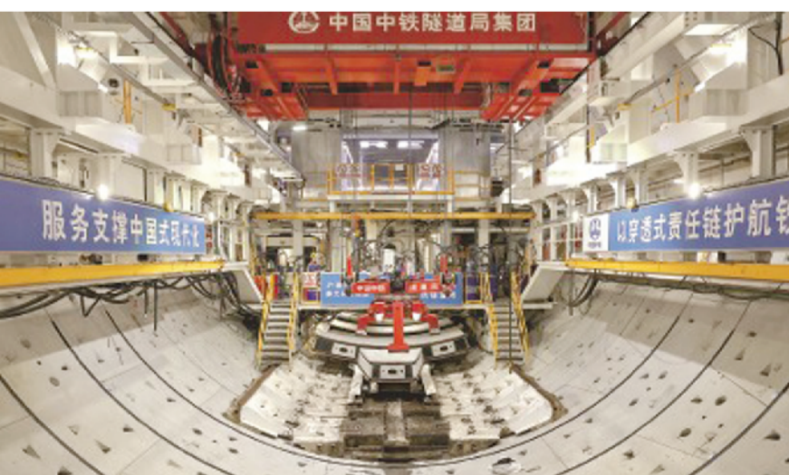
崇太长江隧道采用我国自主研发的世界最大直径高铁盾构机掘进。这是“领航号”盾构机内隧道管片传送口。新华社发（资料照片）
