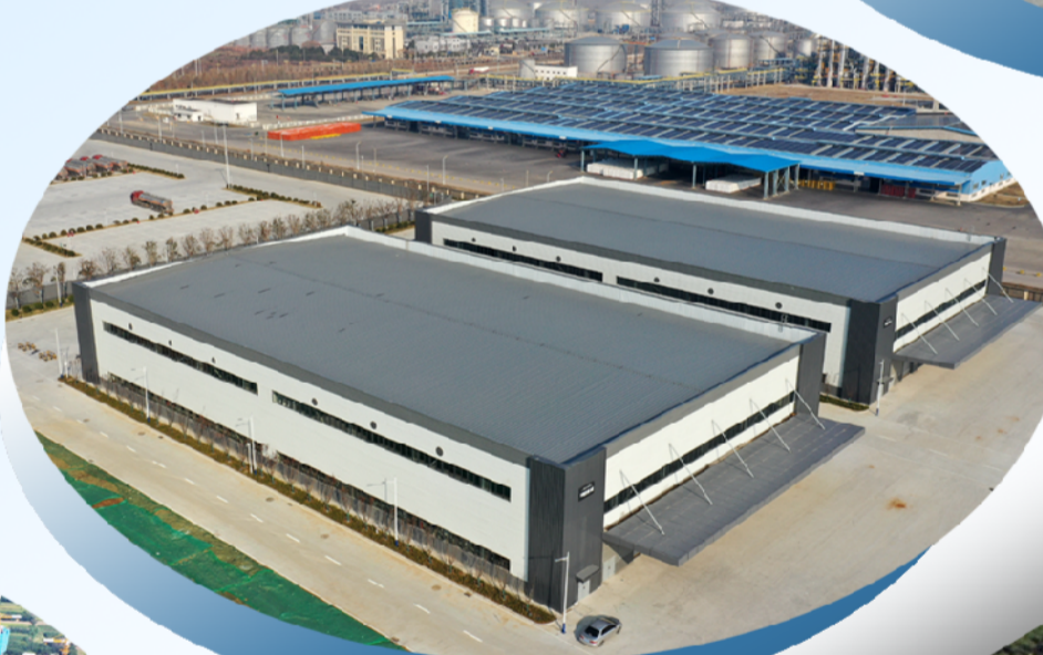
淮南煤化工园区化工物流园项目
