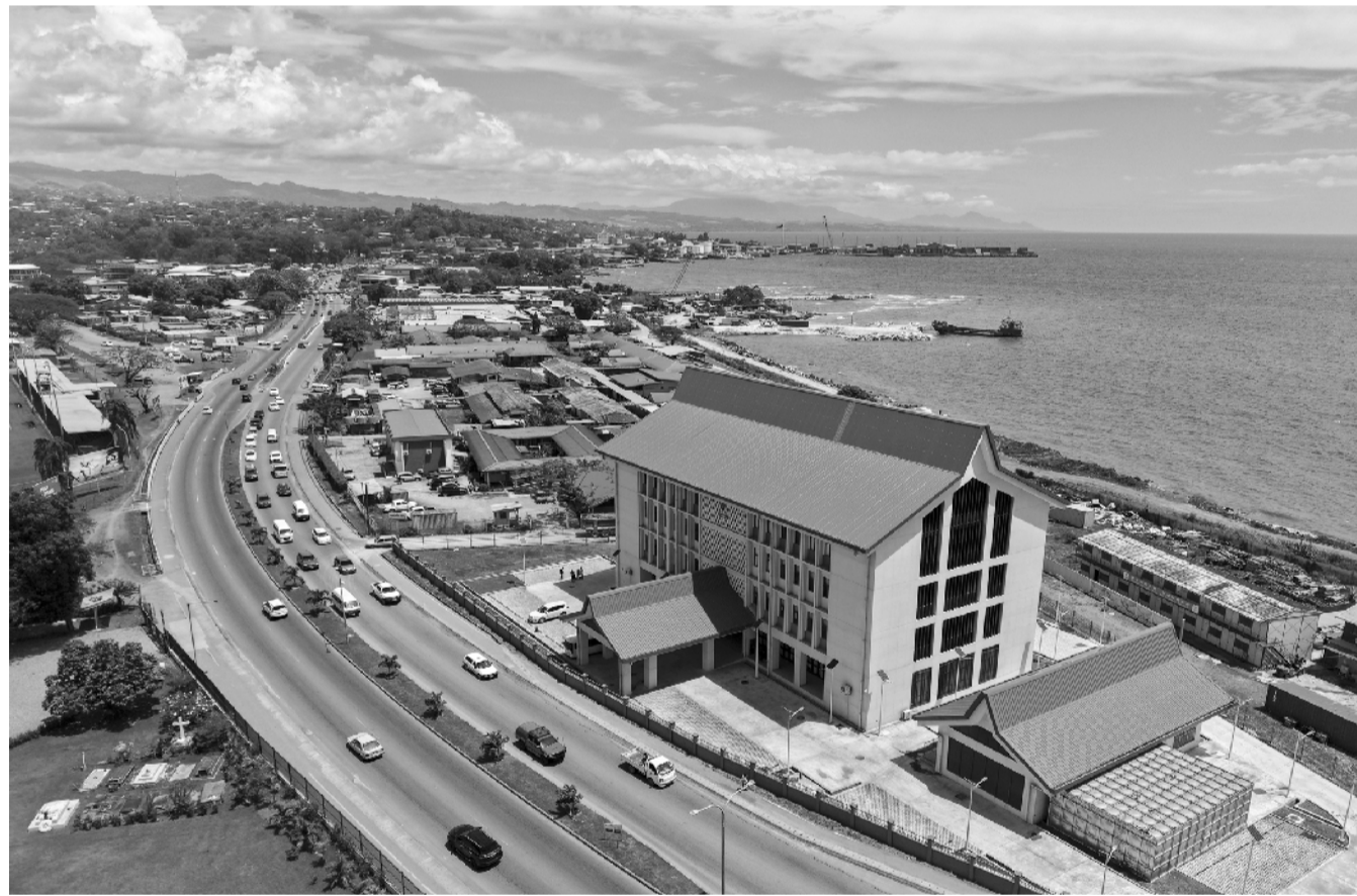
这是近日在所罗门群岛首都霍尼亚拉拍摄的中国援建的所罗门群岛国家转诊医院综合医疗中心及附近景观(无人机照片)。
