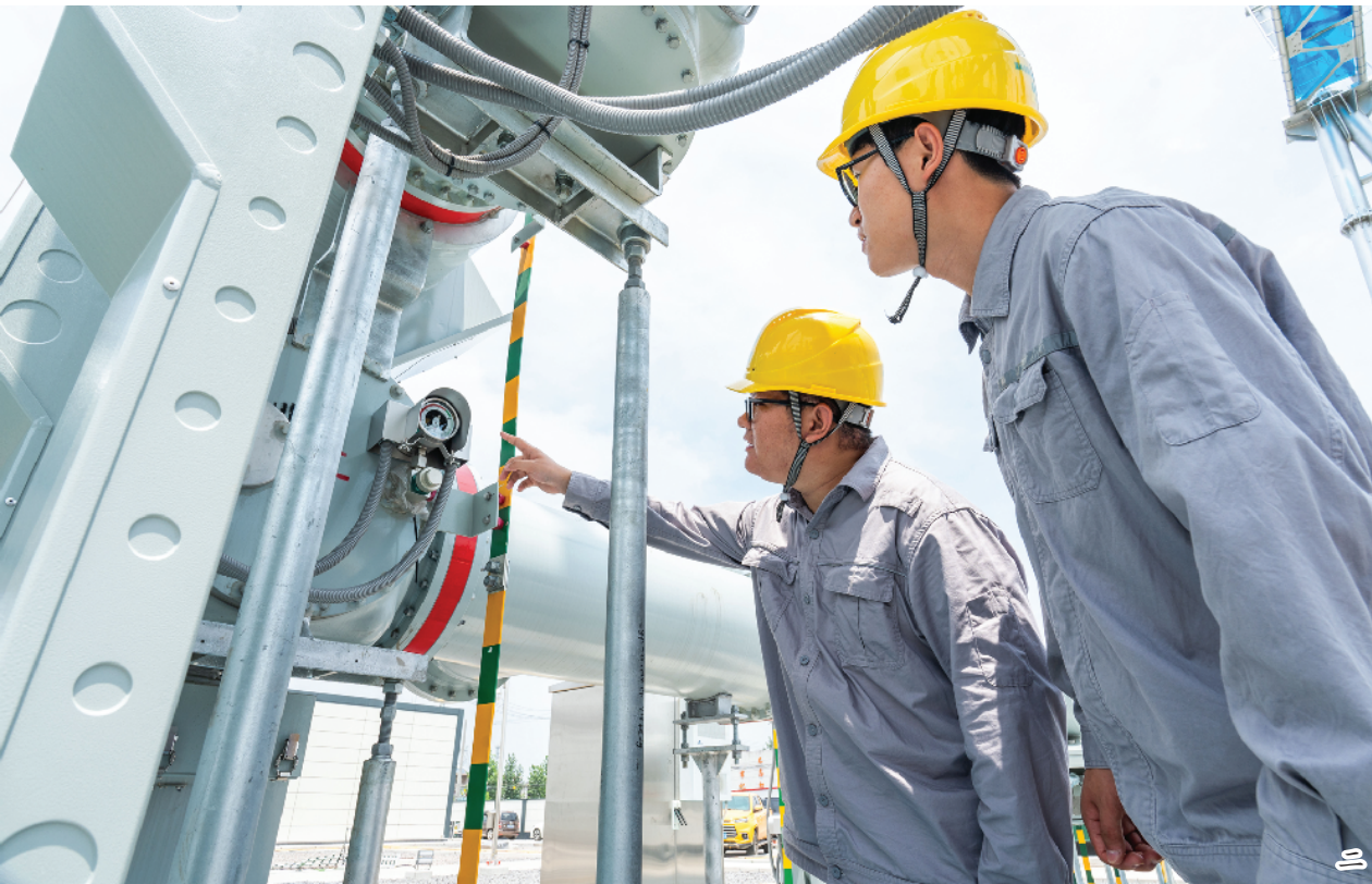
为积极有效应对高温天气,国网淮南供电公司加大设备、线路运维频次,保障电网安全运行。图一、淮南凤台供电公司员工在35千伏丁庄变千伏张巷10线带电安装智能断路器。图二、淮南潘集供电公司员工在110千伏泥河变开展设备验收。 本报通讯员 摄
