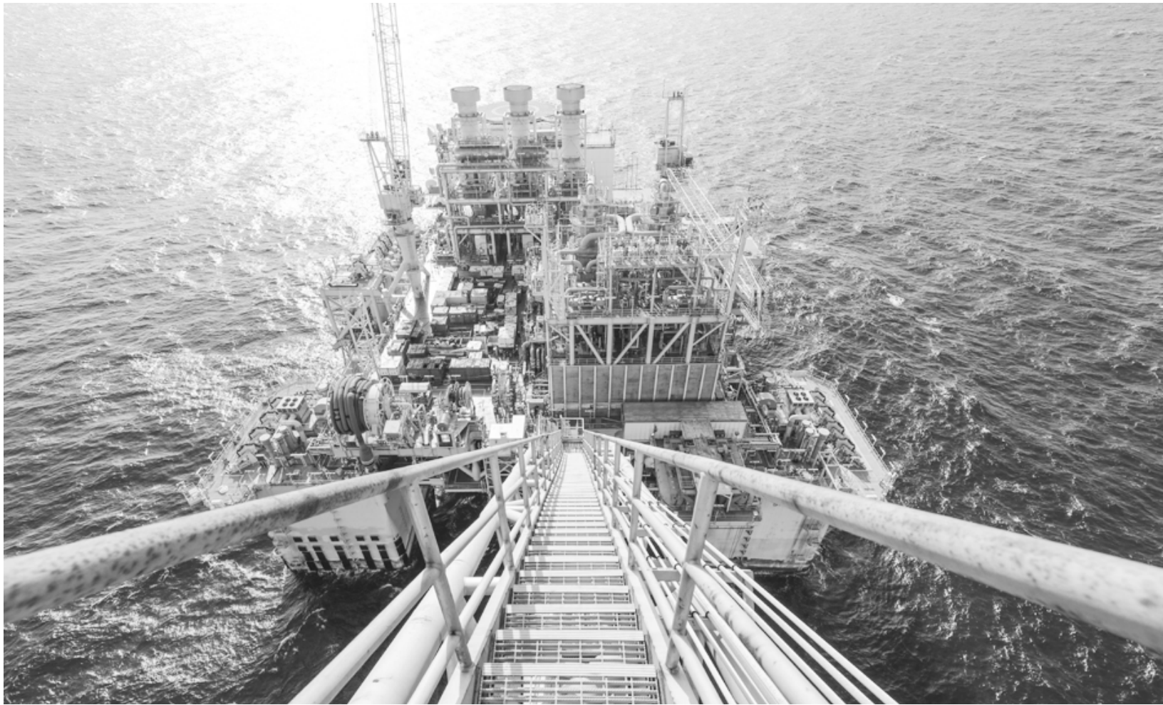
这是 2025 年 4 月从“深海一号”能源站高点俯瞰平台。 6 月 25 日，中国海油宣布，公司在南海水域的“深海一号”大气田二期项目全面投产，标志着我国最大海上气田建成。 新华社 发（中国海油供图）
