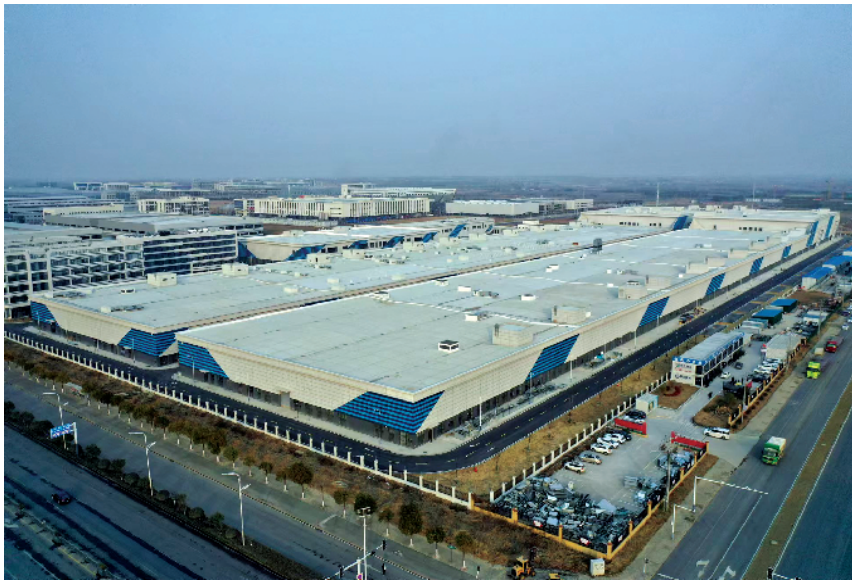
图为安徽50GWh锂电池及材料一体化产业基地“巨无霸”厂房。
