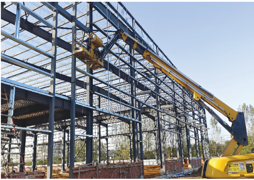
图为天铂新能源电力装备制造项目施工现场。 本报记者 付莉荣 摄
