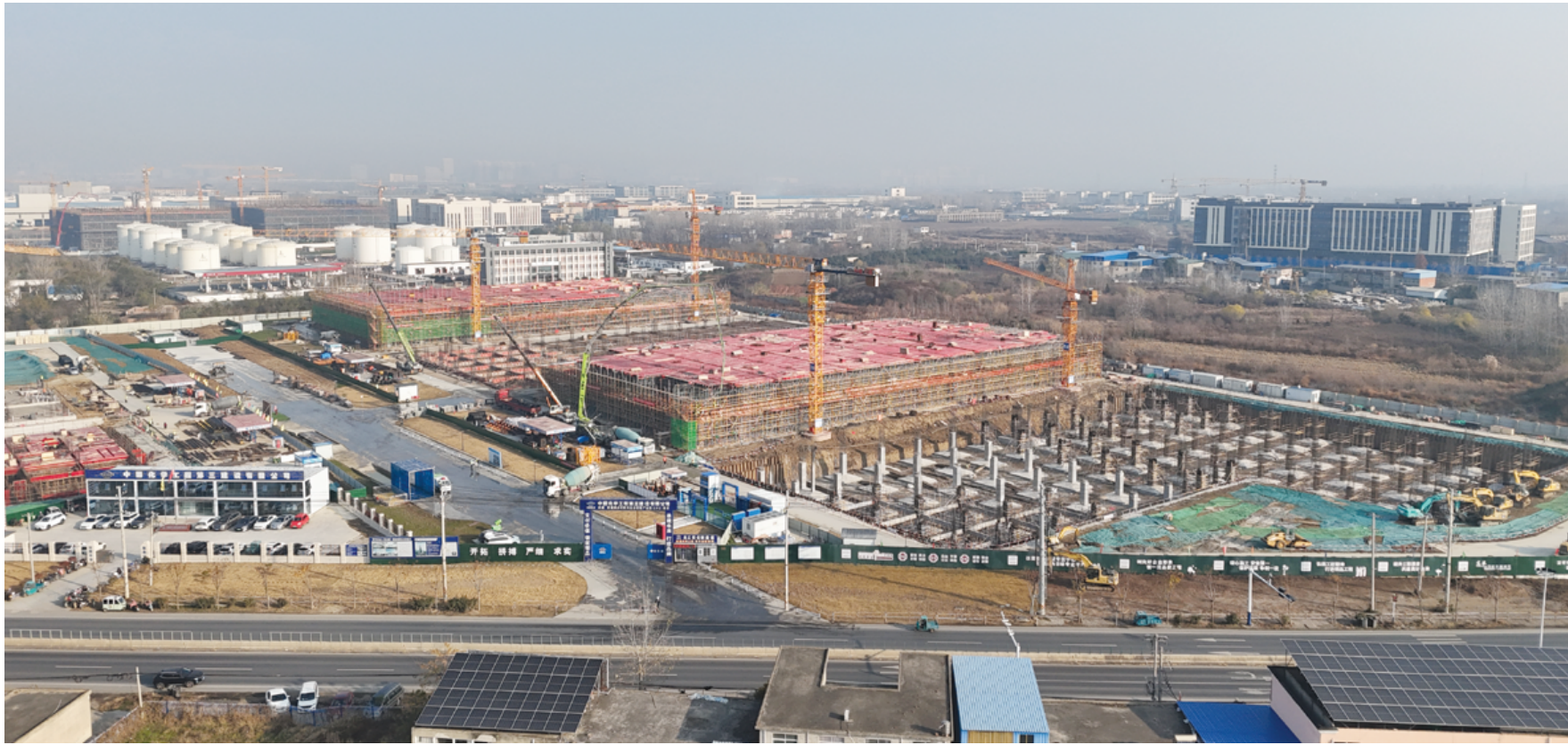
图为曹庵镇乡村振兴生态智慧产业园项目建设现场鸟瞰。
