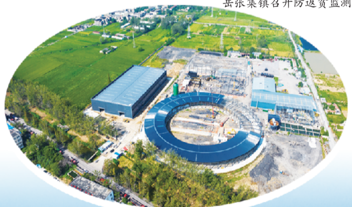
张北循环经济产业园项目建设预计2024年12月份竣工，项目建成投产后，预计年产值9800万元
