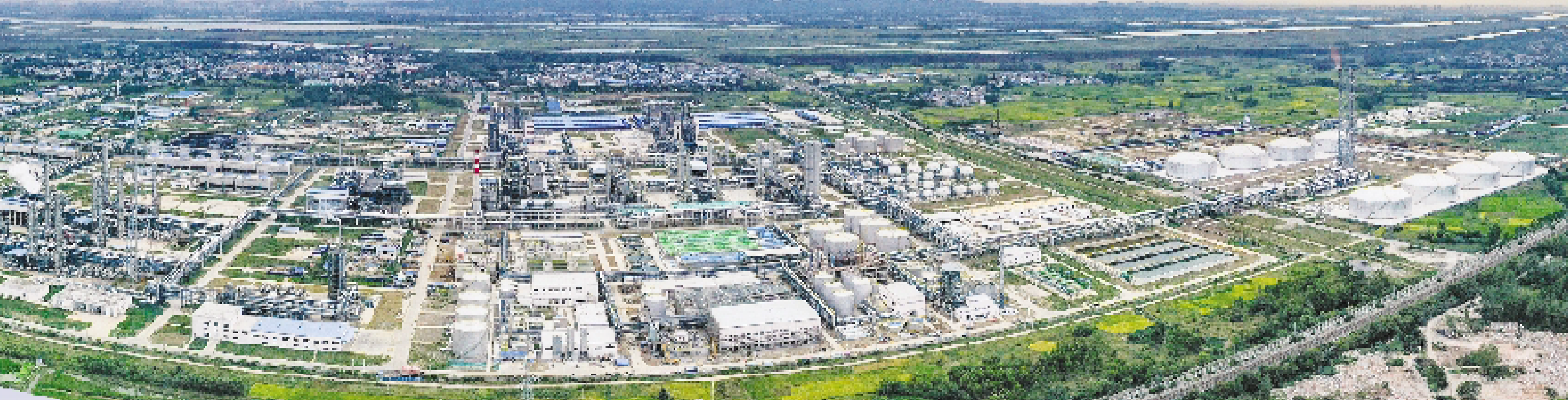
淮南煤化工园区气化炉
