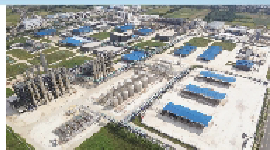
淮南煤化工园区气化炉气化炉气化炉
