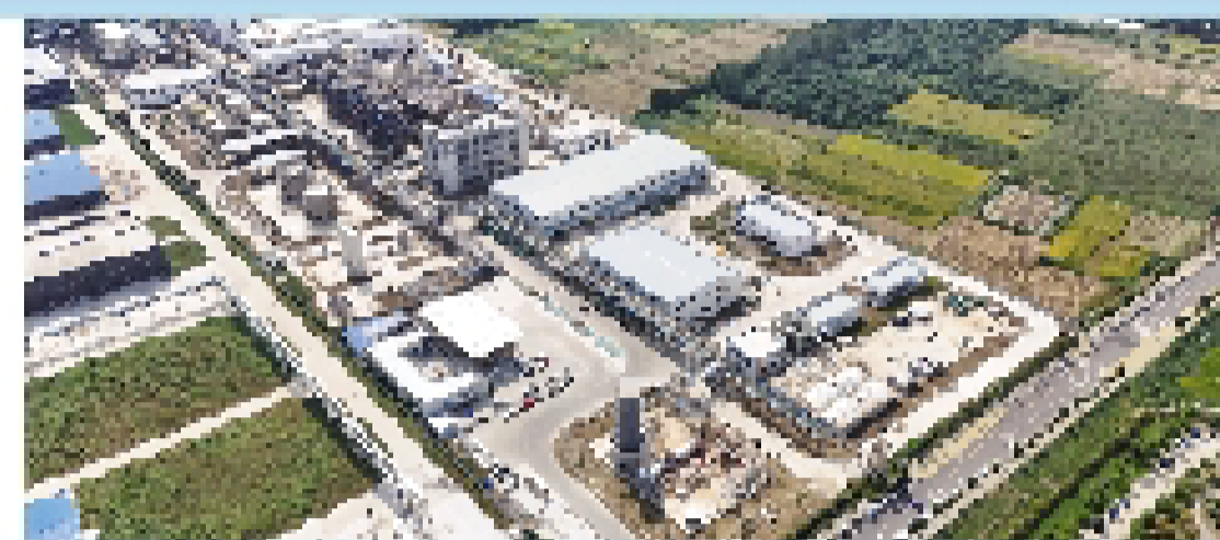
淮南煤化工园区气化炉气化炉气化炉气化炉
