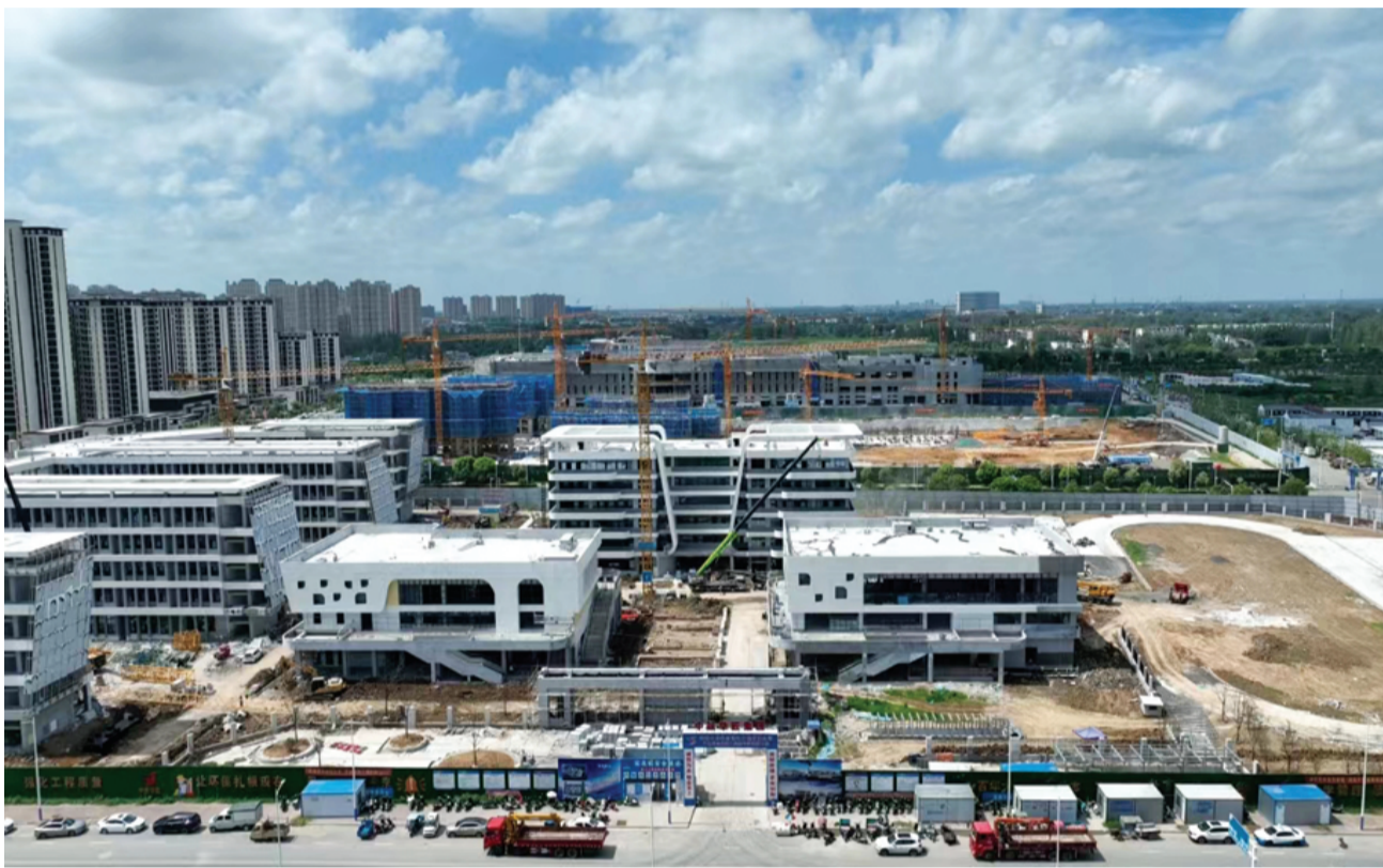
图为凤台县实验中学二建设现场。
