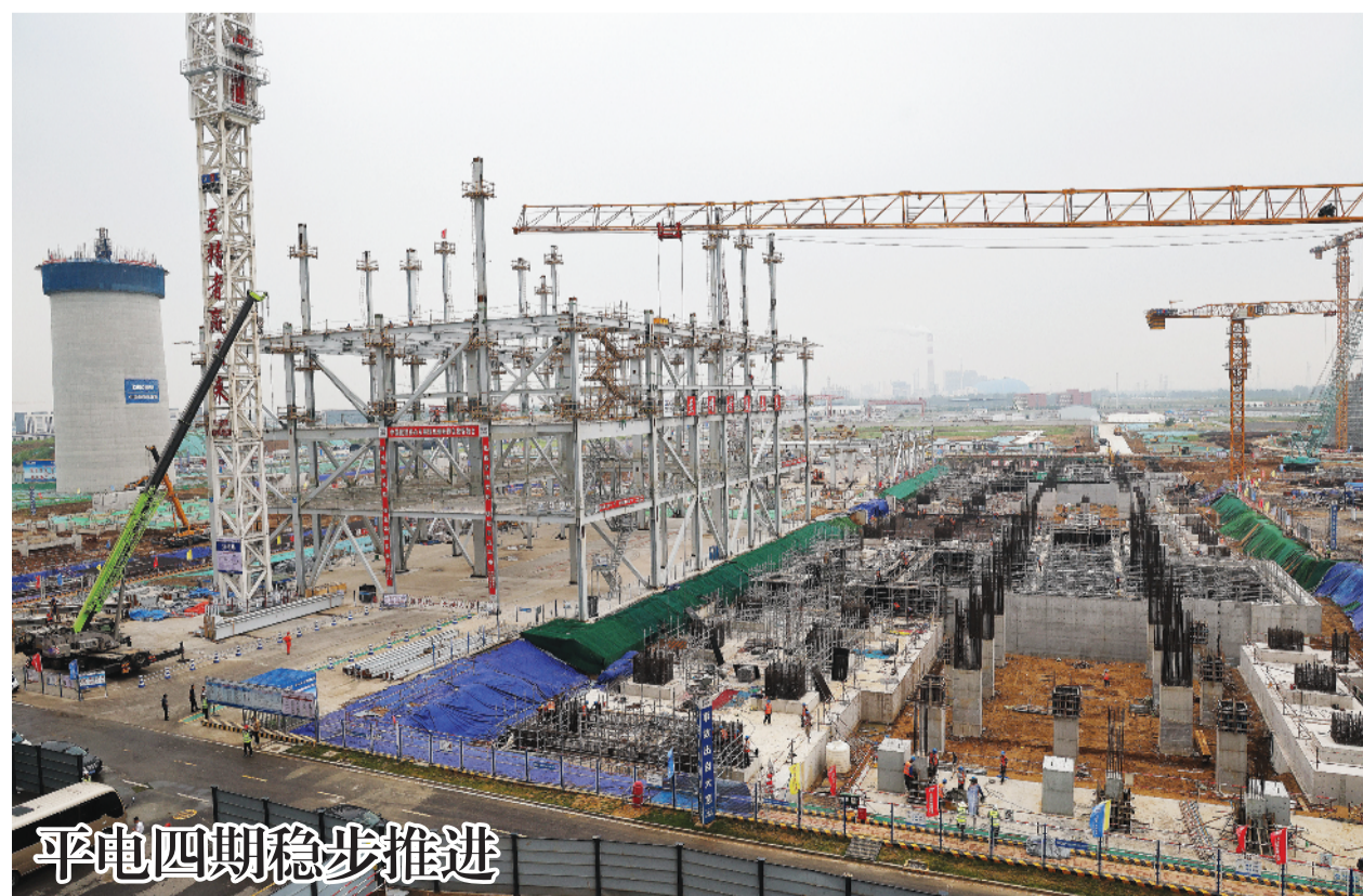
淮南平圩电厂四期2×1000MW超超临界燃煤发电机组工程是安徽省“十四五”支撑性电源项目,自2023年12月29日开工以来,项目秉承资源节约型、环境友好型社会理念,高质高效地建设世界一流清洁高效燃煤示范电站。按计划,平电四期一号机组将于明年年底建成发电。图为6月25日的施工现场。 本报记者 张越 摄
