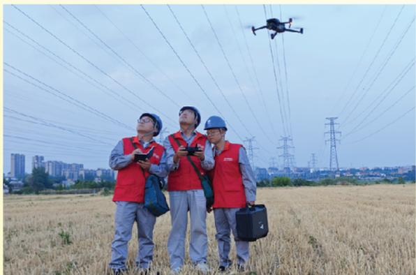
淮南供电公司员工冒高温开展输电线路无人机巡检作业。
