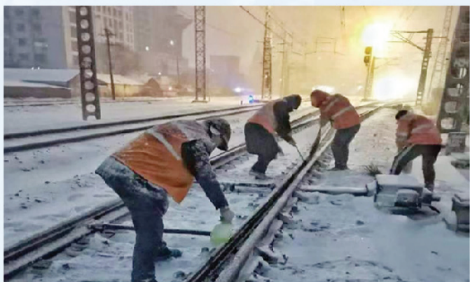
清扫铁道线道岔积雪，确保畅通。
