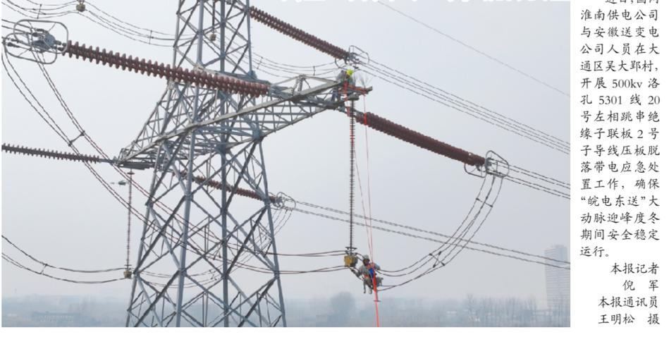
近日,国网淮南供电公司安徽送变电公司人员在大通区吴大郢村,开展500kV洛孔5301线20号左相跳串绝缘子联板2号子导线压板脱落带电应急处置工作,确保“皖电东送”大动脉迎峰度冬期间安全稳定运行。
