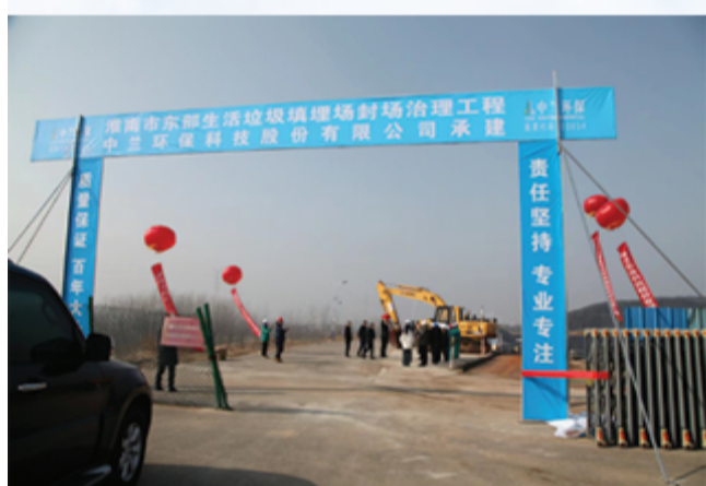
我市东部生活垃圾填埋场封场项目开工
