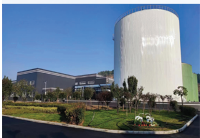
厨余垃圾资源化综合利用项目二期投入运行
