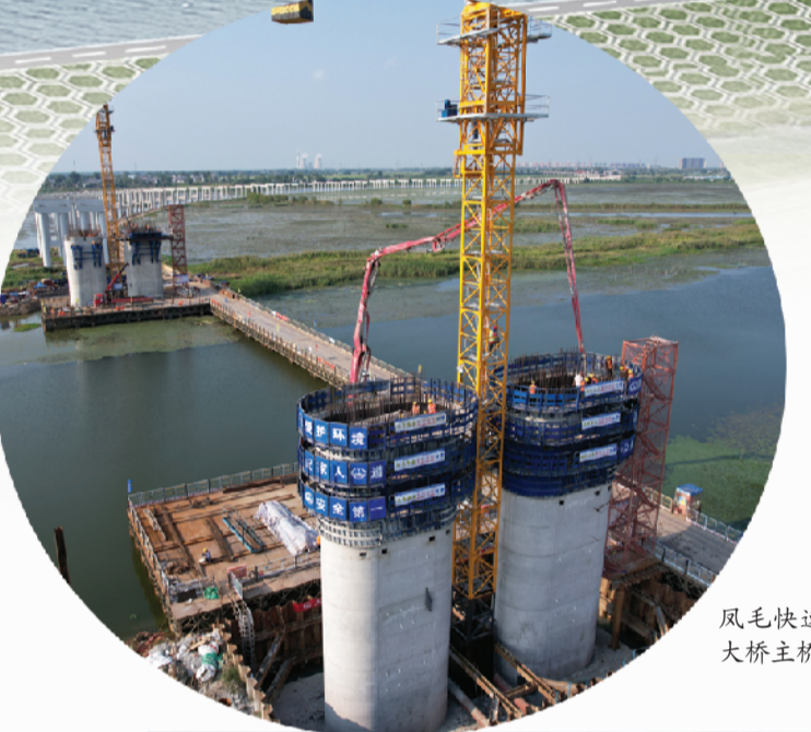
凤毛快速通道西肥河特大桥主桥架施工现场
