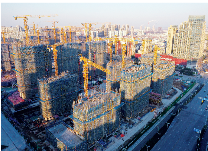
图为田家庵区北赵店棚户区改造项目施工现场。 本报记者 张越 摄
