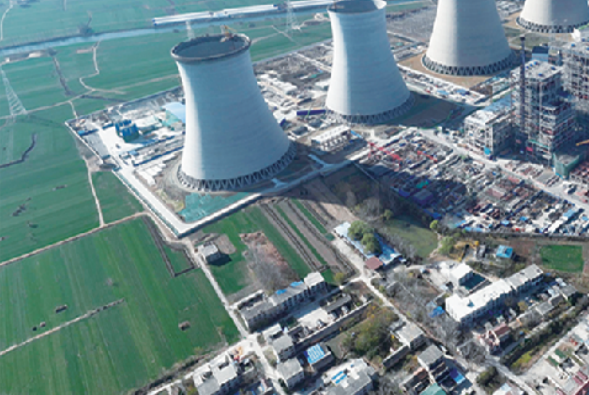
板集电厂二期施工现场
