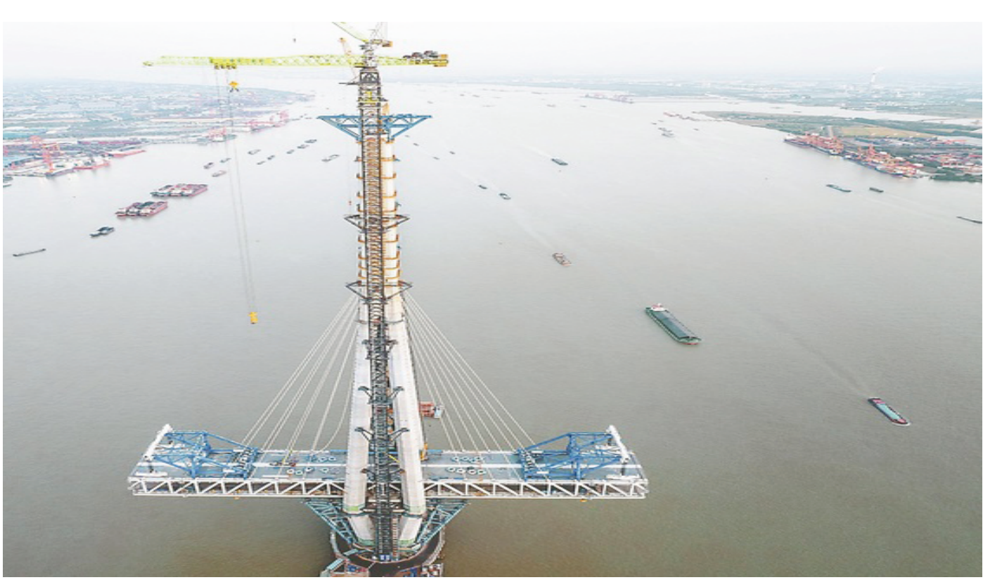
10月29日，常泰长江大桥钢桁梁吊装作业有序推进，大桥两座主塔都已完成封顶，天星洲专用航道桥钢桁梁架设也进入冲刺阶段，预计十二月实现跨中合龙。 赵振宇 摄 视觉江苏网供图
