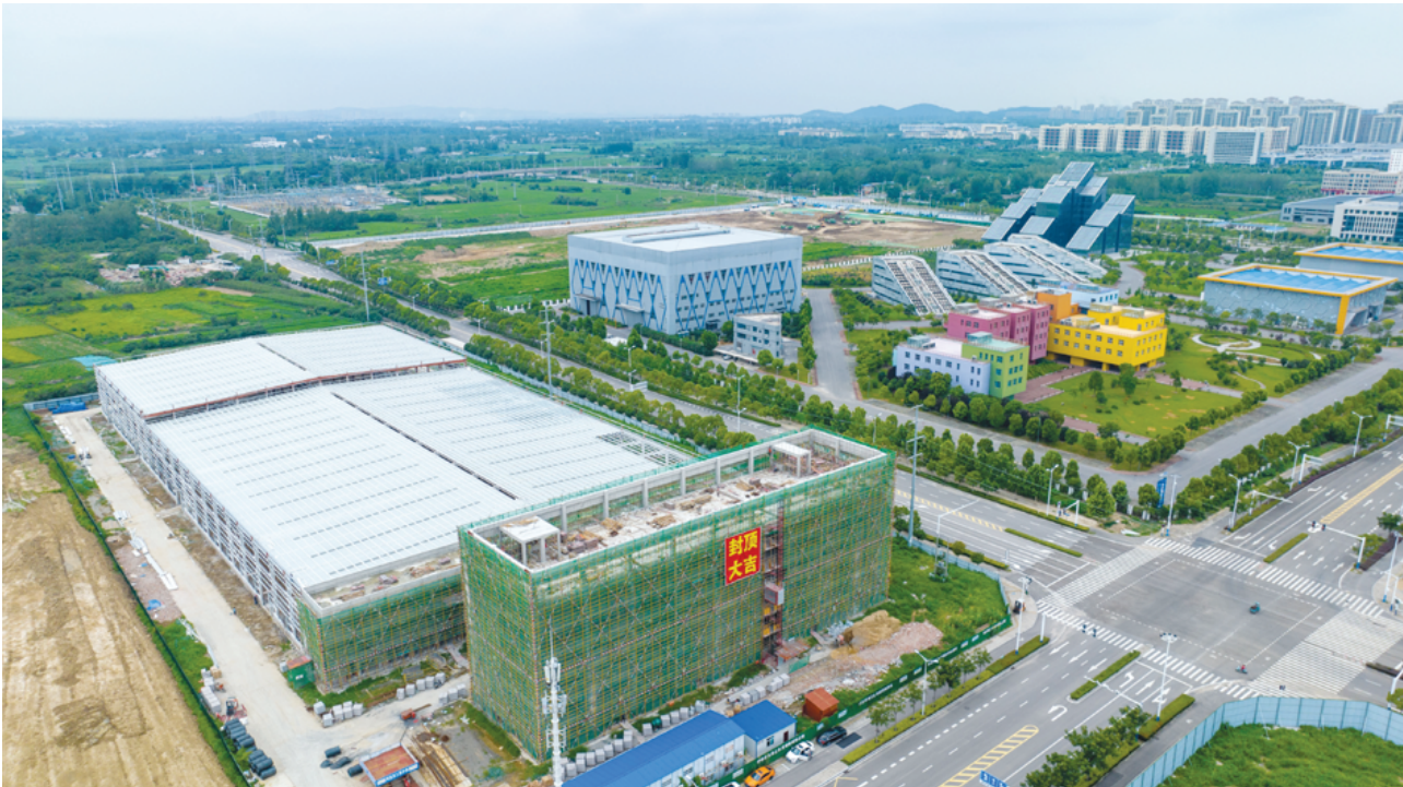
图为高空拍摄建设中的淮南高新区安徽明然新能源汽车三合一电驱生产基地一期项目建设工地。 本报记者 倪 军 摄
