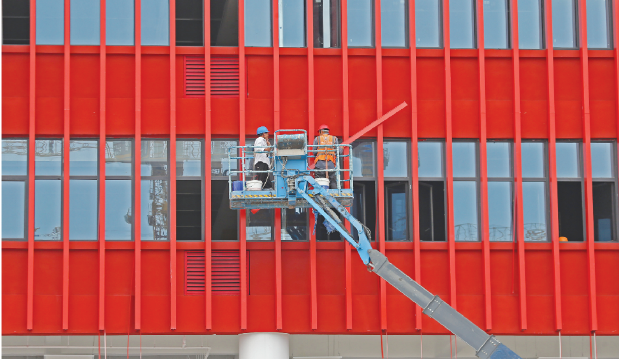
△淮南高新区，北师大淮南实验学校项目建设现场，工人们紧张有序地施工。 倪 军 摄
