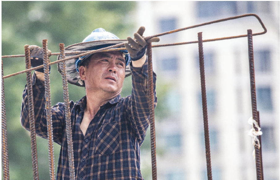
△项目工地上，钢筋工在施工。 金广良 摄
