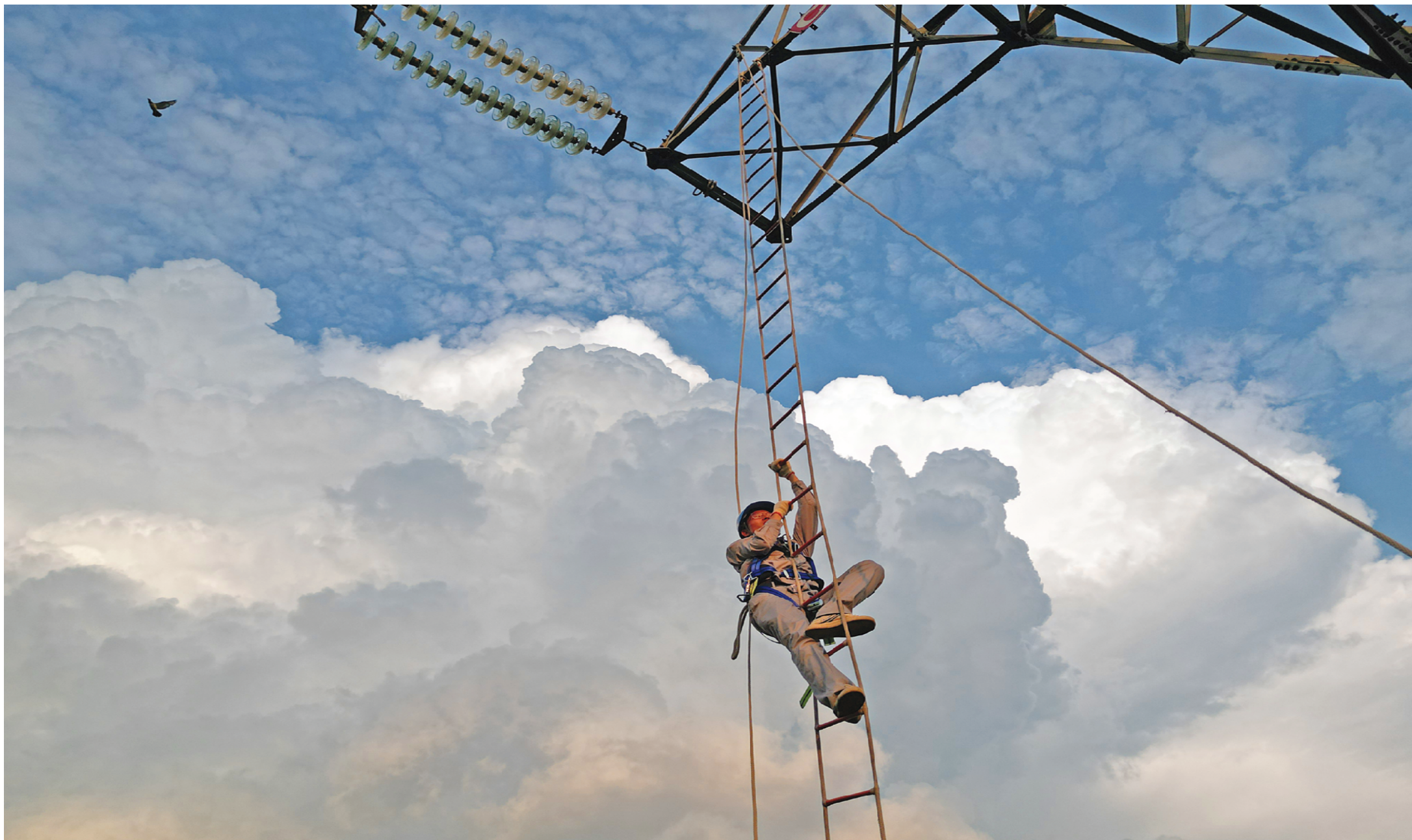
△国网淮南供电公司输电青年苦练本领备战高温保供电。 王明松 摄
