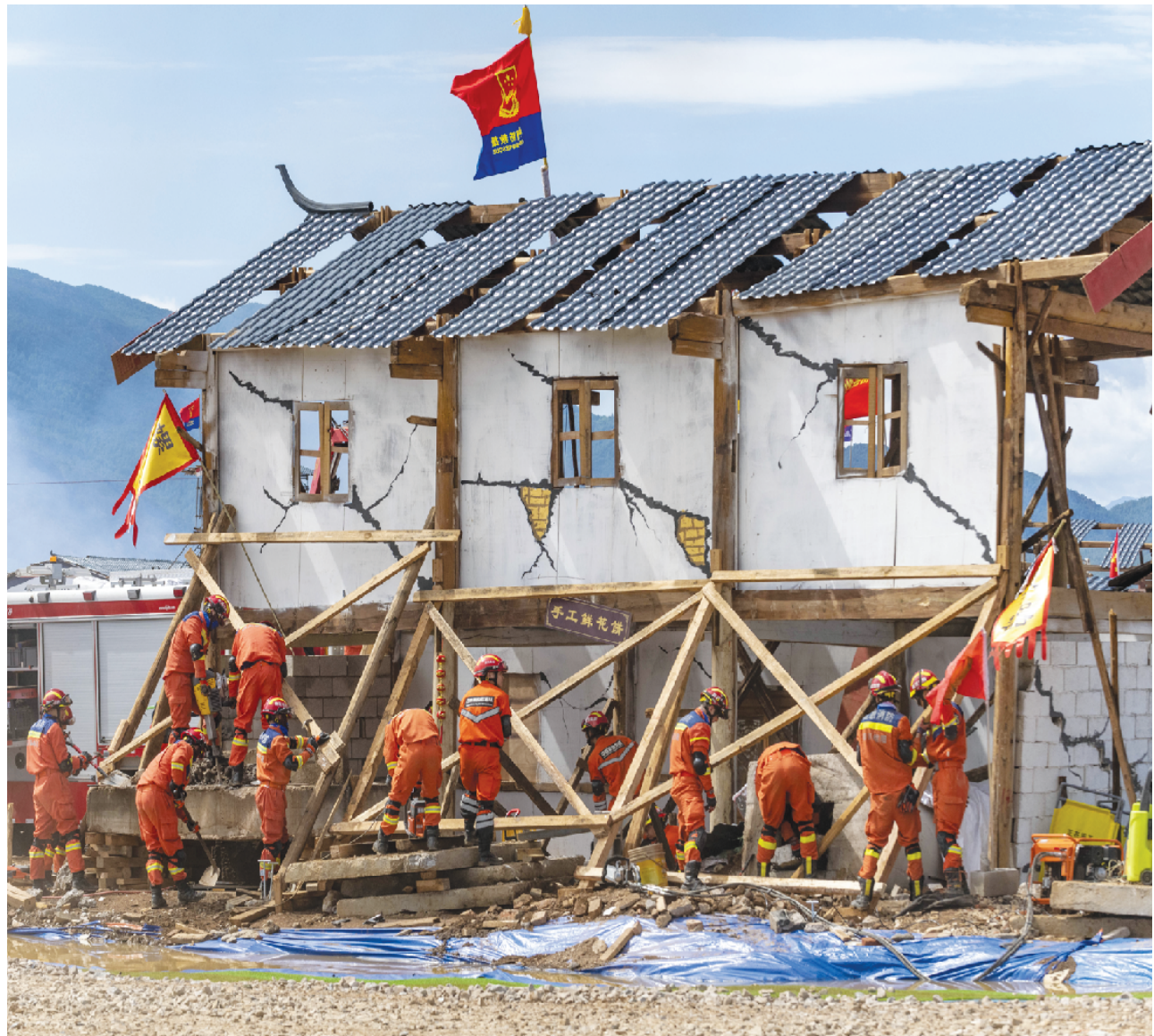
5月16日，参演人员在丽江演习现场对受损建筑物进行排险加固。
