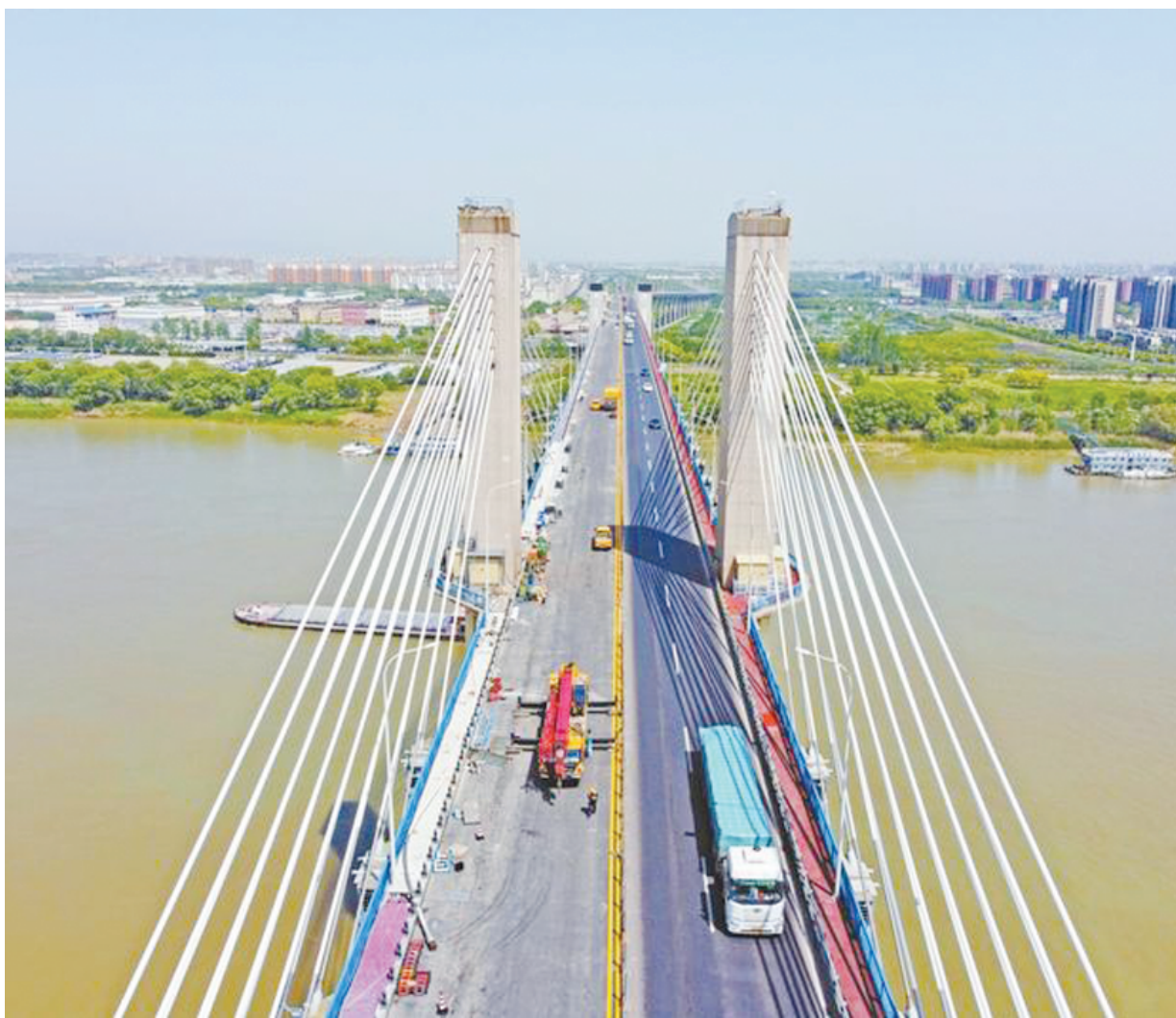
索锚端固施拧困难、小角度工况下新索穿孔孔位偏等问题。
