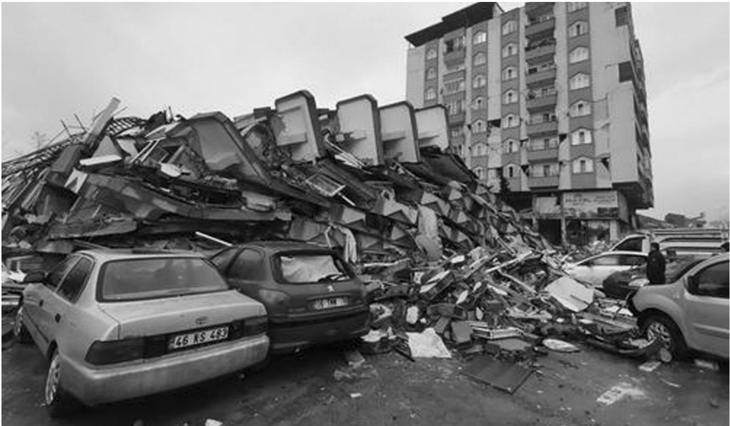
这是 2 月 7 日在土耳其卡赫拉曼马拉什拍摄的一处倒塌的建筑(手机照片)。 新华社记者 李振北 摄
