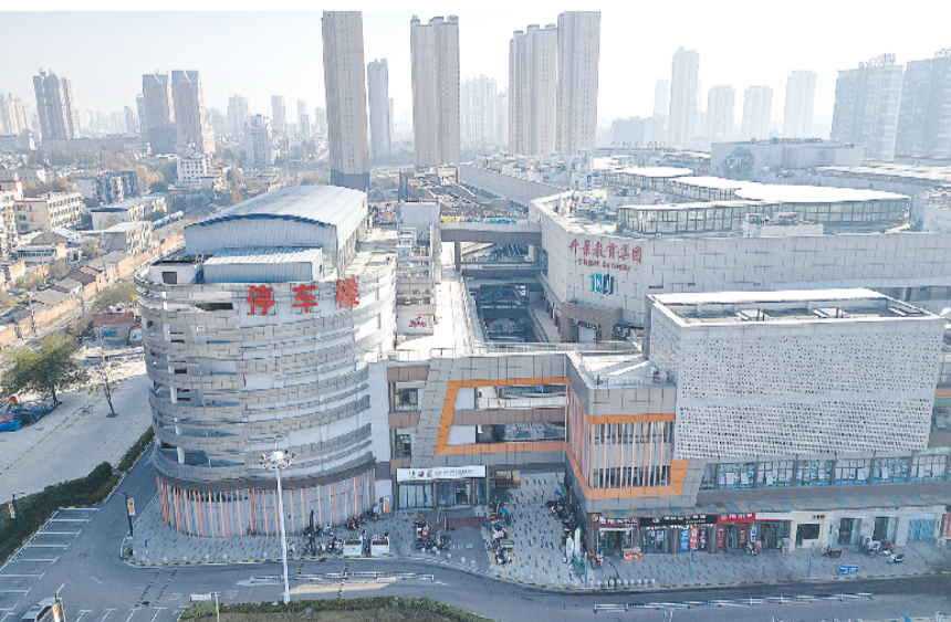
淮南吾悦广场停车楼。
