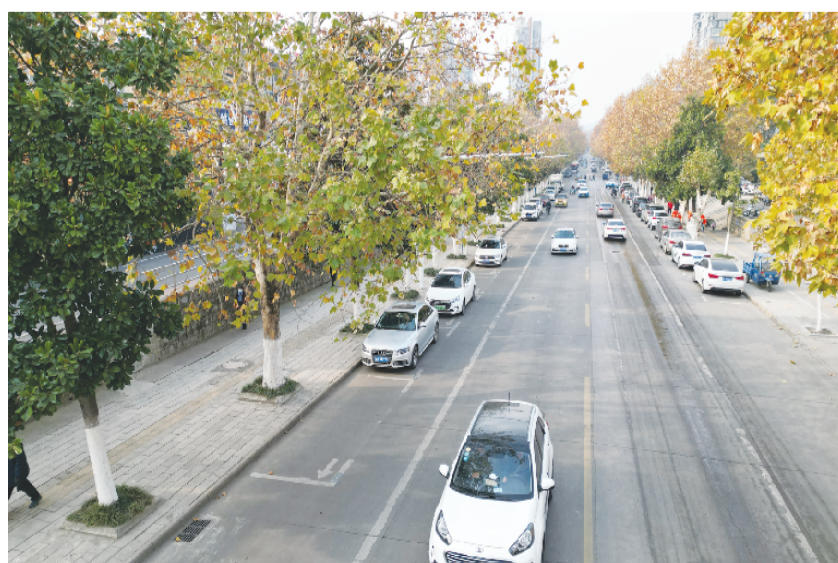
金家岭路智能化停车系统已启用。
