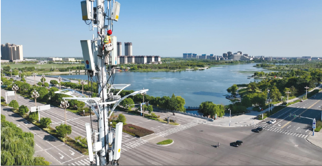
图为淮南铁塔公司维护人员攀登30米高通信铁塔,检修通信设备,保障通信畅通。
