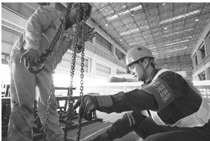
10月22日，大唐洛河发电分公司4号机组A级检修进入设备解体的关键阶段，当日，该分公司各专业分工协作密切配合，将高压缸和低压缸转子顺利吊出，这一重大节点的顺利完成，为大修工作如期完成奠定了基础。 本报通讯员 姚晓山 摄
