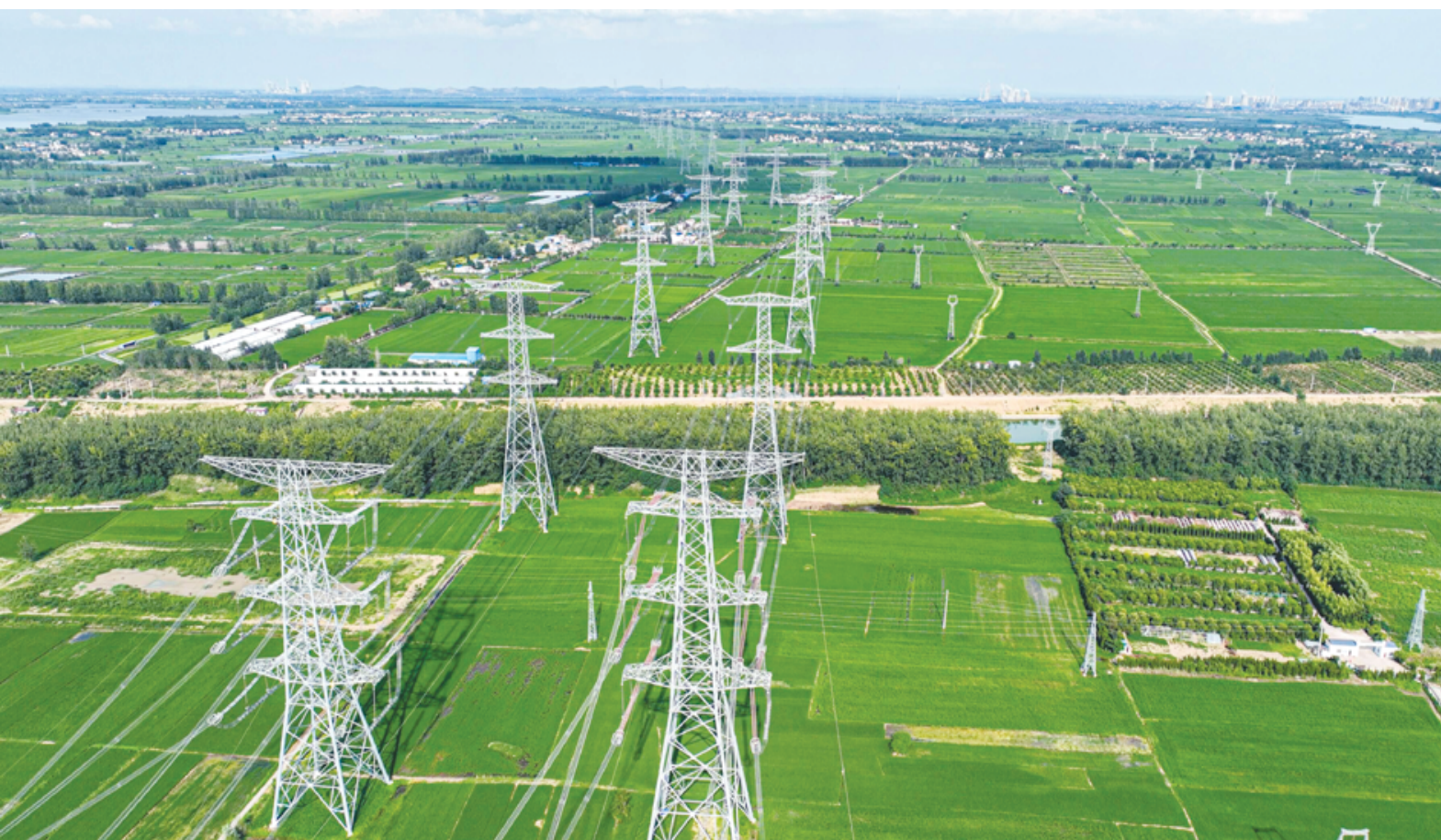
◁皖电东送1000千伏淮上线路工程是我国首个特高压交流同塔双回路的示范工程，是“十二五”国家重点工程项目，总投资185.36亿元。
