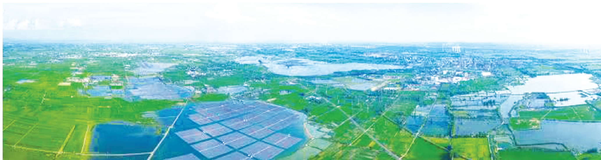
无人机拍摄的全球最大水面漂浮光伏电站的全貌。
