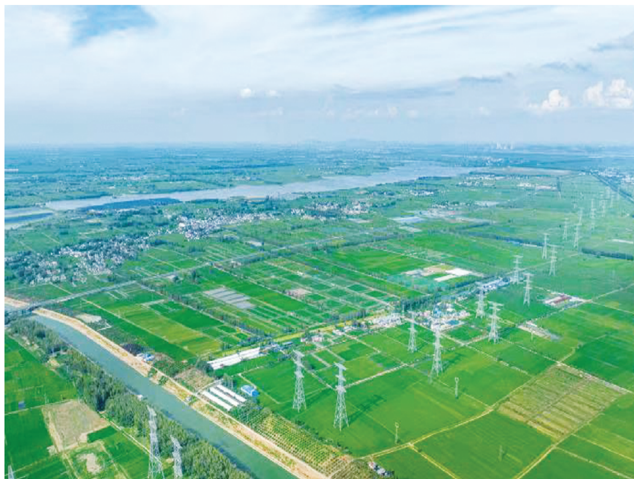
被誉为“咽喉工程”的淮河大跨越工程,跨越段全长2445米,塔高198米。
