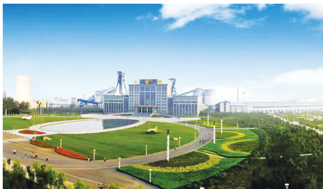
图为年产1000万吨的现代化矿井顾桥矿全貌。
