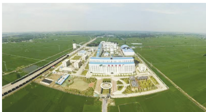
淮河能源控股集团煤业公司潘集选煤厂鸟瞰图。
