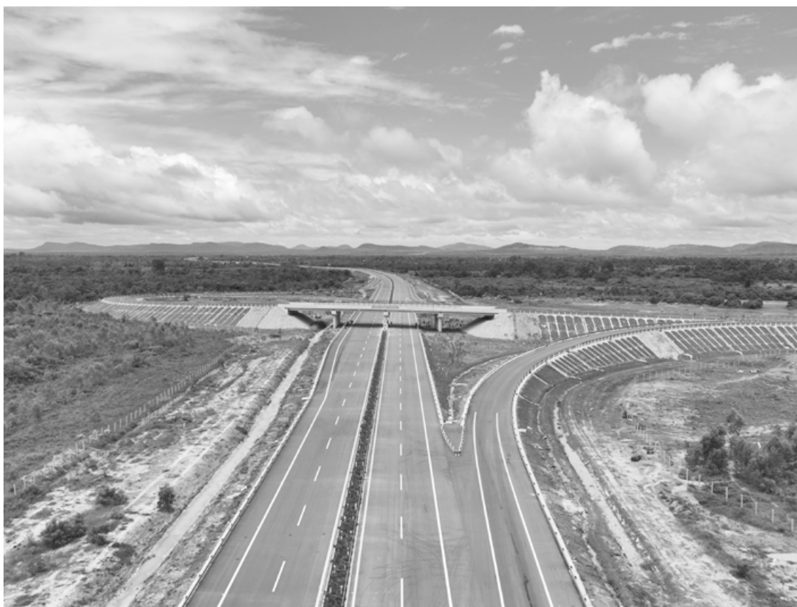
这是7月16日在柬埔寨西哈努克省拍摄的金港高速公路项目。 新华社发(李震摄)
