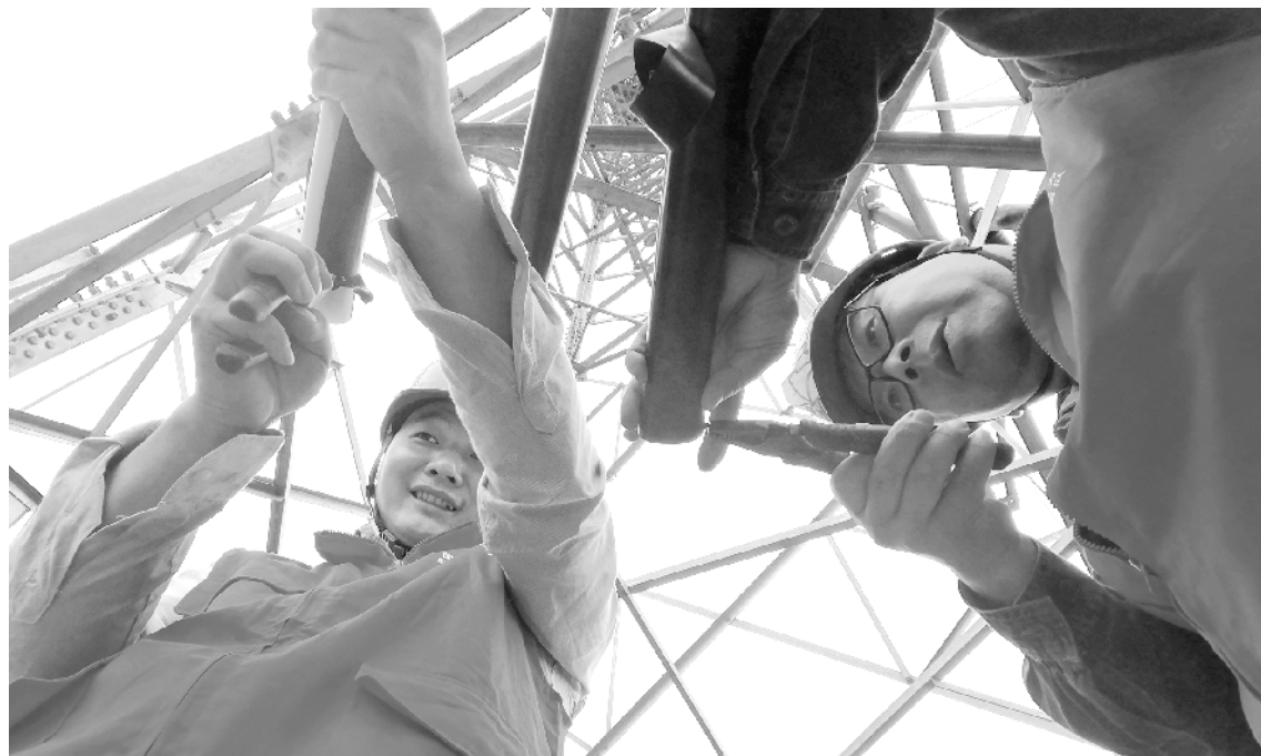
近日,凤台县供电公司对35千伏焦康3617线33号塔电缆头开展终端用户不停电消缺作业,有力保障迎峰度夏期间电力可靠供应。 本报记者 周莹莹 本报通讯员 吴烽 摄
