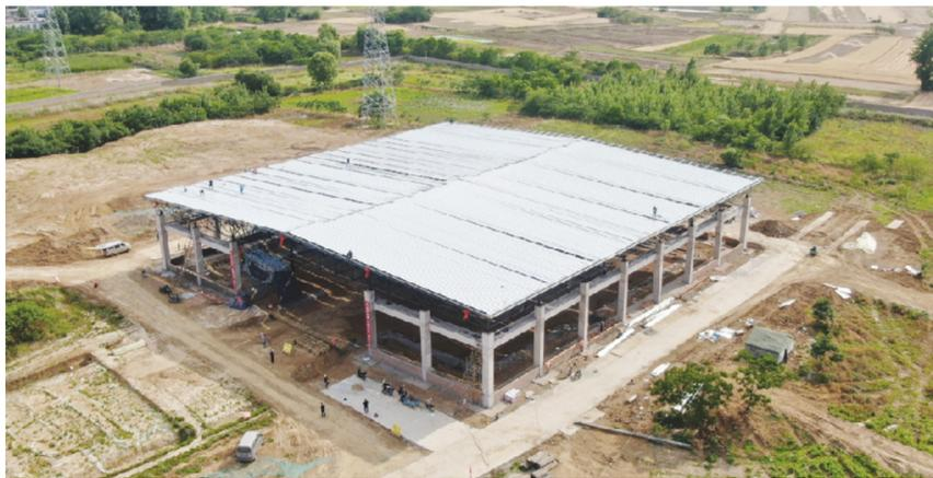
“5月14日,21吨重的首跨网架完成吊装。考虑到保护古墓,吊装设备不能在墓室范围内作业,就采用了260吨和150吨两台大型履带吊。”张飞虎说,260吨位的吊车放在古墓南侧开展作业,稳妥地避开了附近的高压线,保证了施工安全。近日投入使用的升降式压板机,是工程建设的又一个“亮点”,大大提升了屋面板安装进度。
