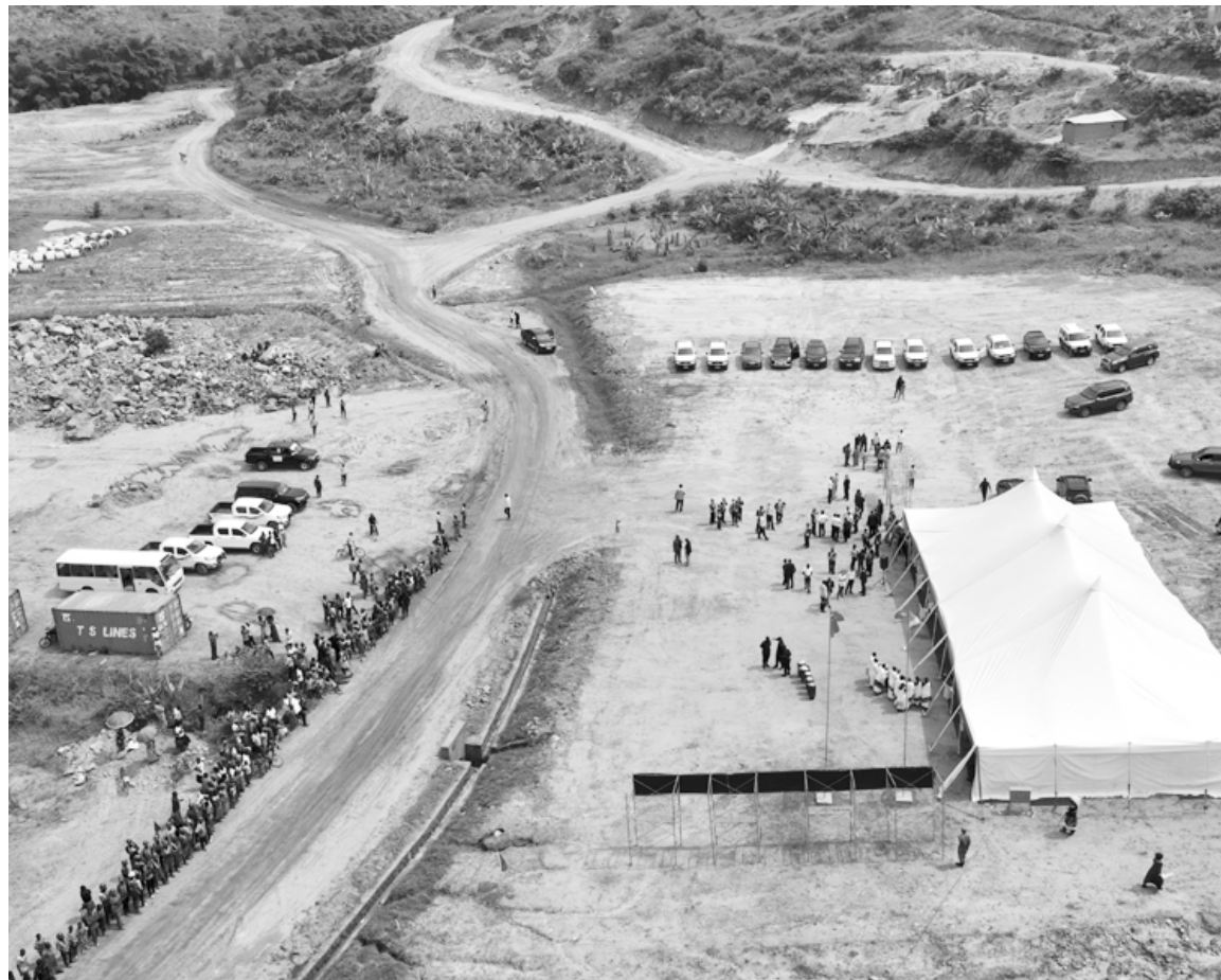
这是5月21日在卢旺达北方省加肯凯市拍摄的中企承建卢旺达那巴龙格河二号水电站项目开工仪式现场（无人机拍摄）。
