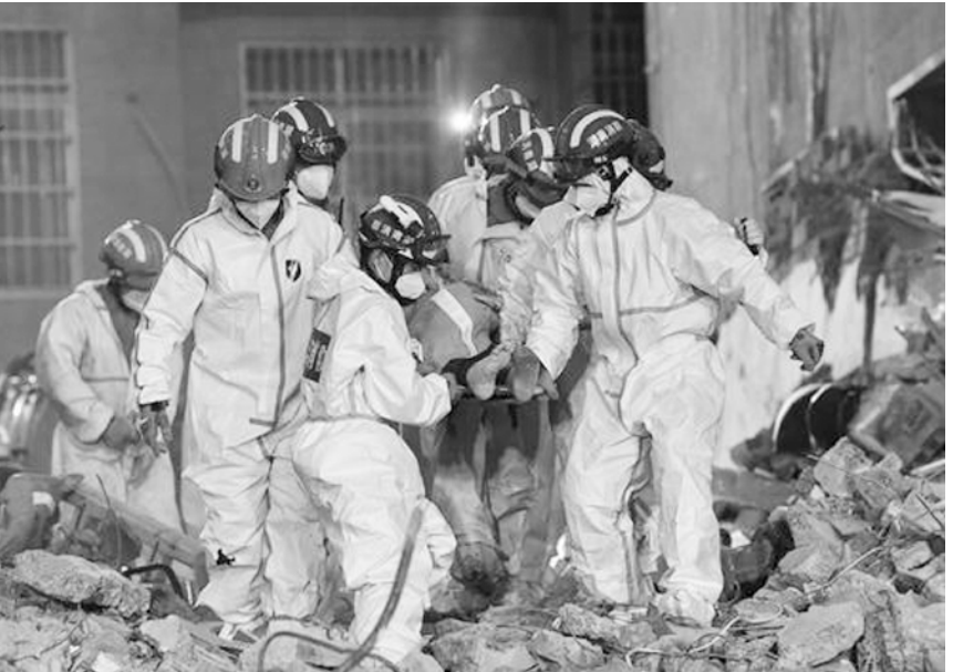
建新通报，经过紧急救援，6日3时3分，长沙居民自建房倒塌事故现场救援工作结束，事故现场被困、失联人员已全部找到，共救出10人，遇难53人。 在发布会现场，湖南省委常委、
