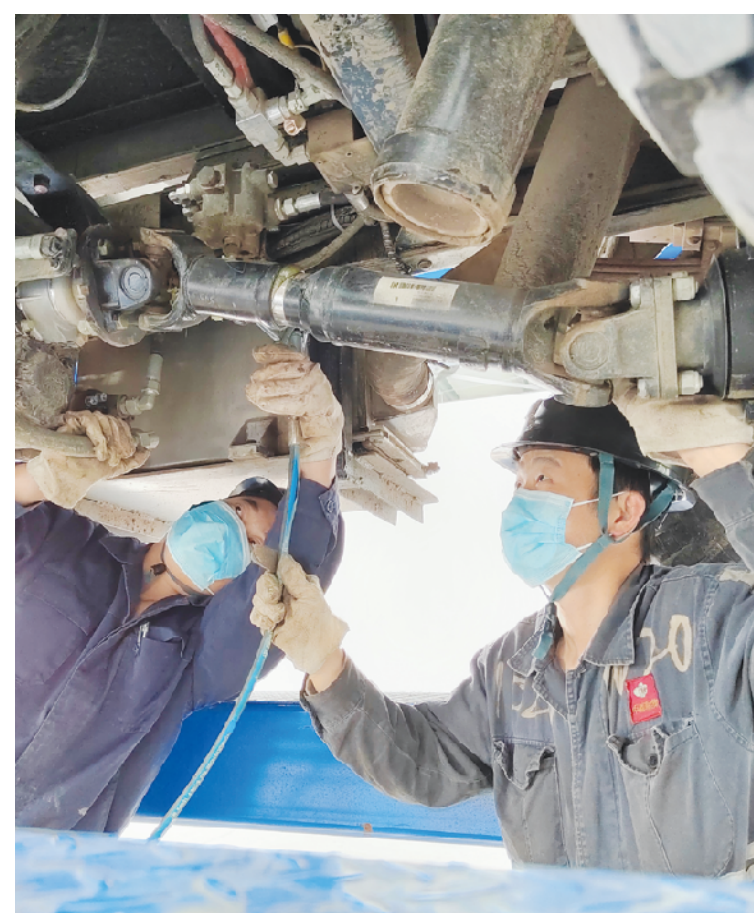
▲刘庄煤矿强化自主检修能力保障安全生产。
