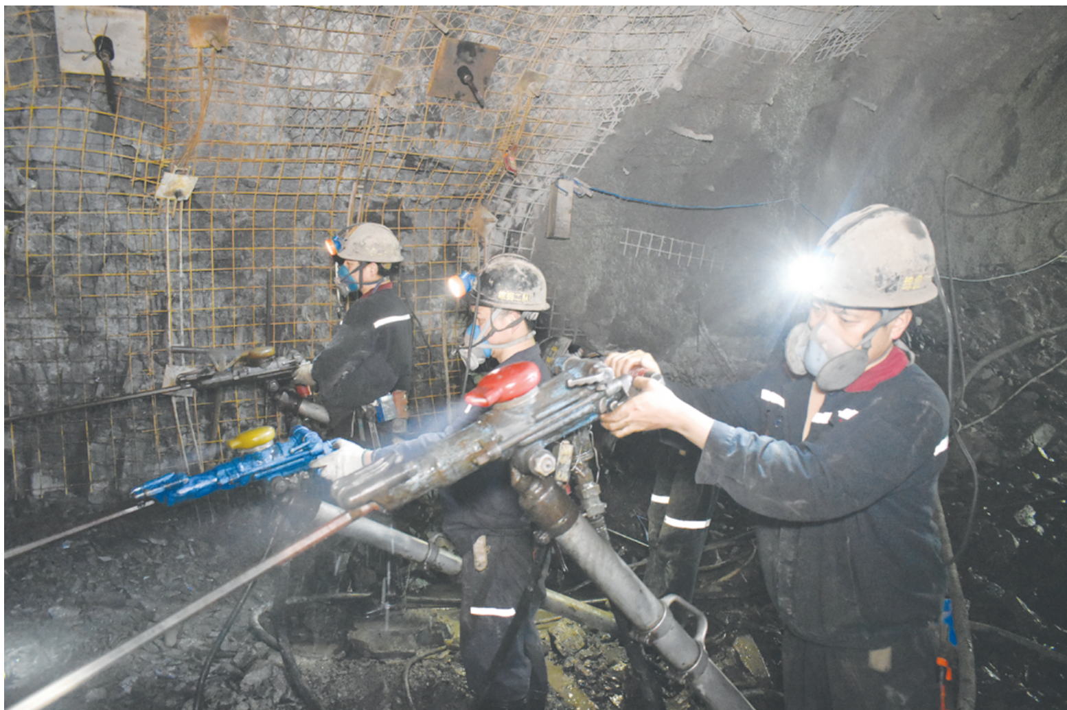
▲中煤新集一矿对掘进头进行打钻支护。
