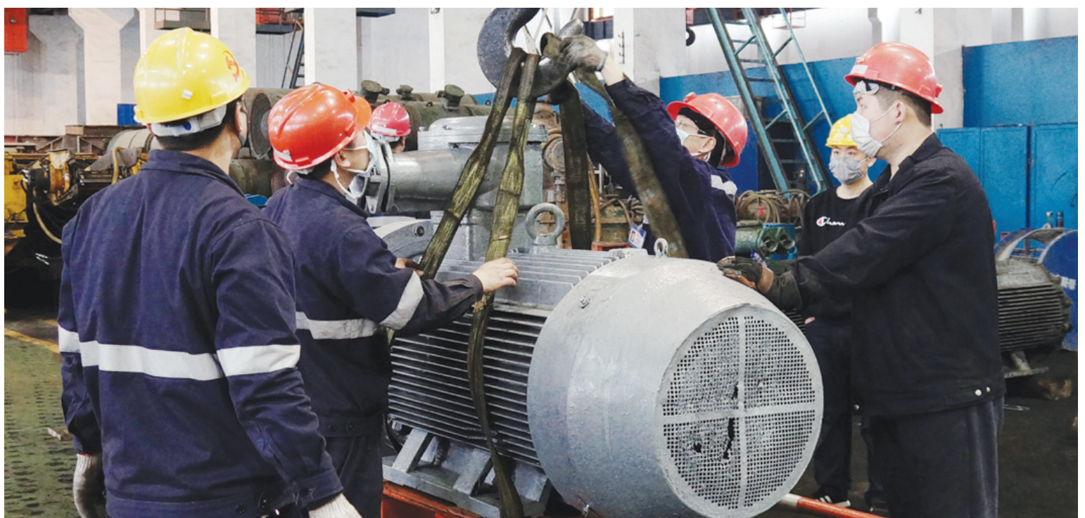
▲顾桥煤矿机电修配中心在吊装维修好的电机,准备做入井前的调试。
