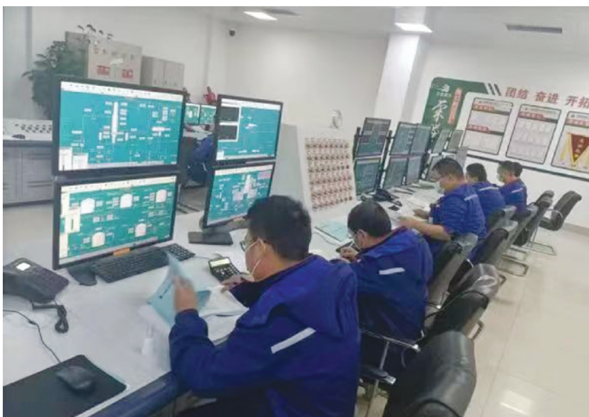
安徽(淮南)现代煤化工产业园：安徽嘉玺新材料公司的中央控制室运转如常，企业生产规模已恢复疫情之前的水平。 本报记者 贾 静 摄
