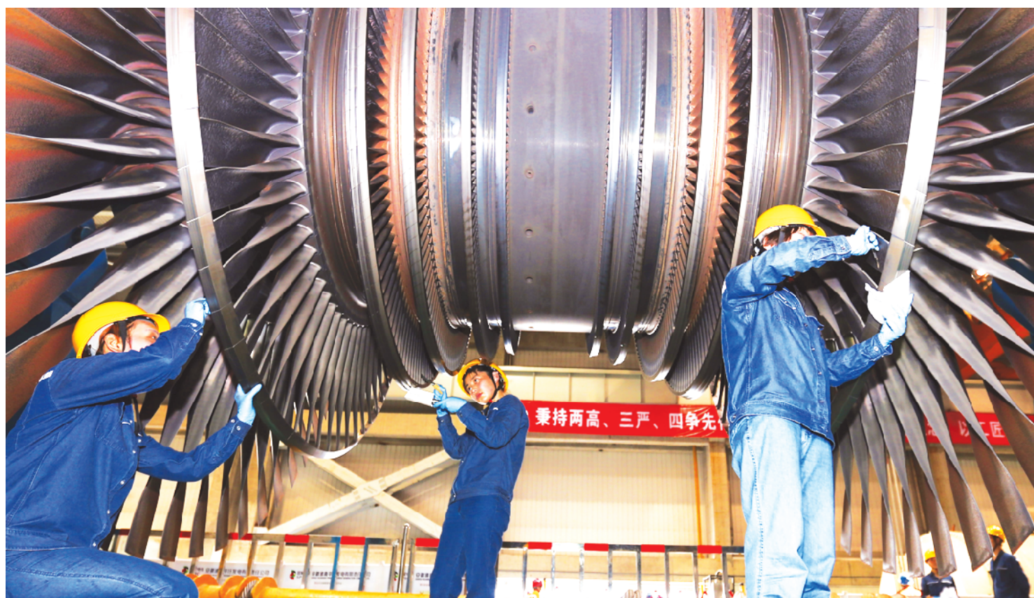
坚守岗位的电力女工。
