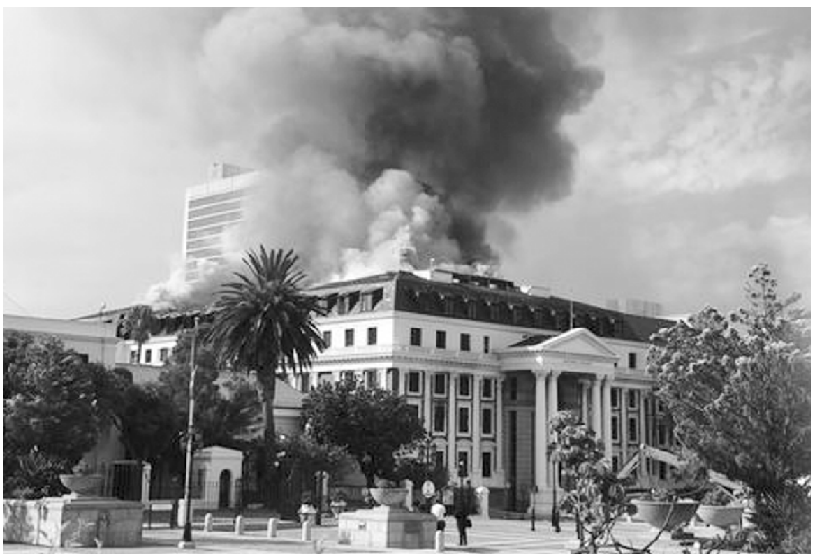
1月3日,在南非立法首都开普敦,议会建筑发生复燃。
